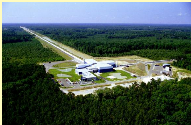
Veduta aerea del Laser Interferometer Gravitational-Wave Observatory, situato presso Livingston, in Louisiana. Sono riconoscibili i due bracci perpendicolari dell'interferometro laser. [Cortesia LIGO]
